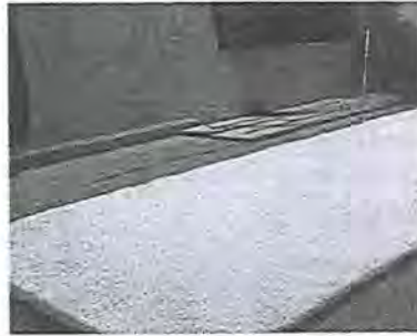
Figura 2 – Vista del montaje del manto de poliéster sobre el piso de la cámara.
