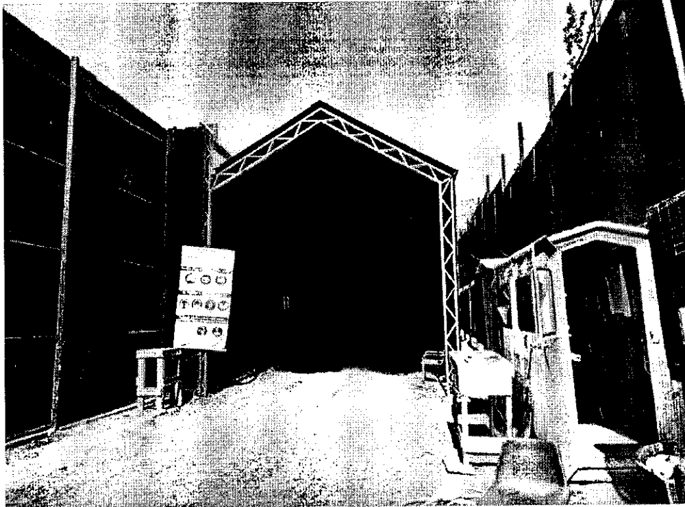
Figura 12 Túnel acústico en obra para camión mezclador
