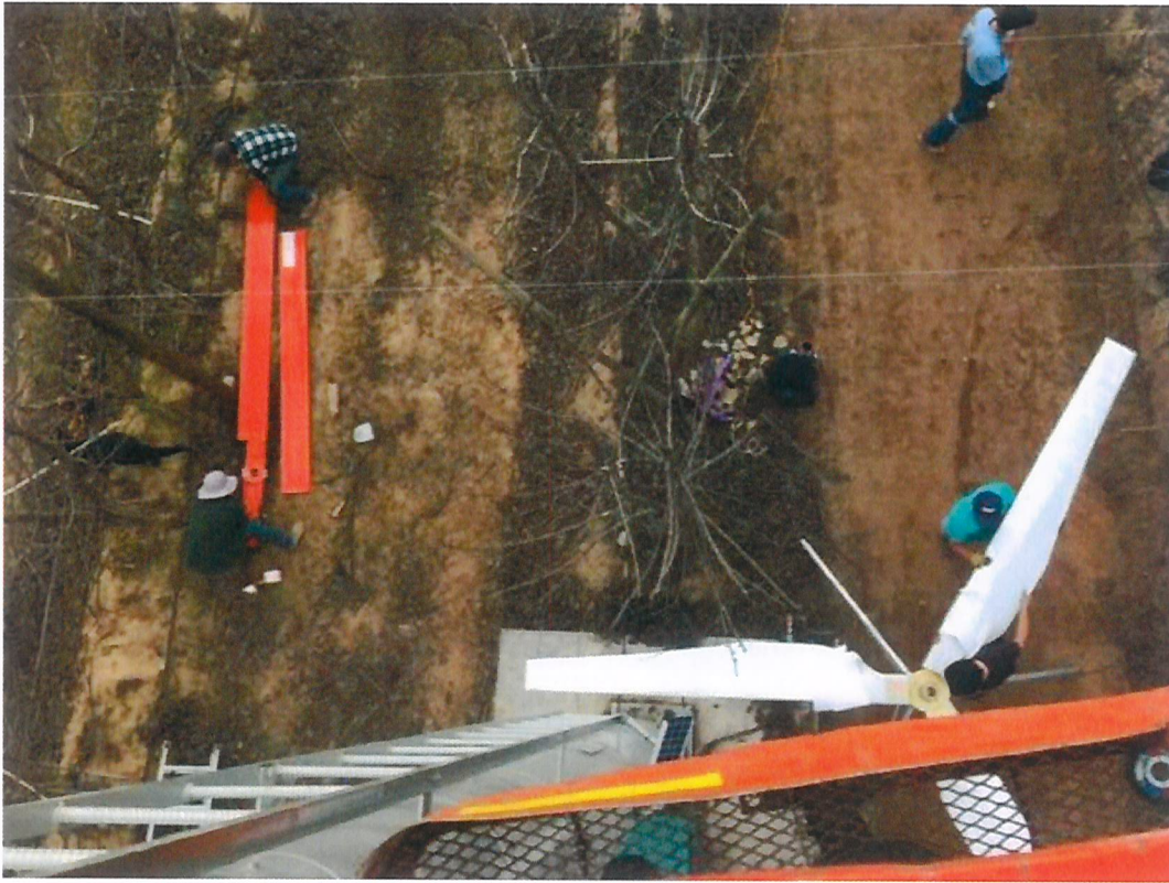
MONTAJE DE HELICES DE 3 ASPAS
