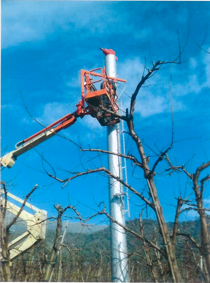
DESMONTADA LA HELICE DE 2 ASPAS
