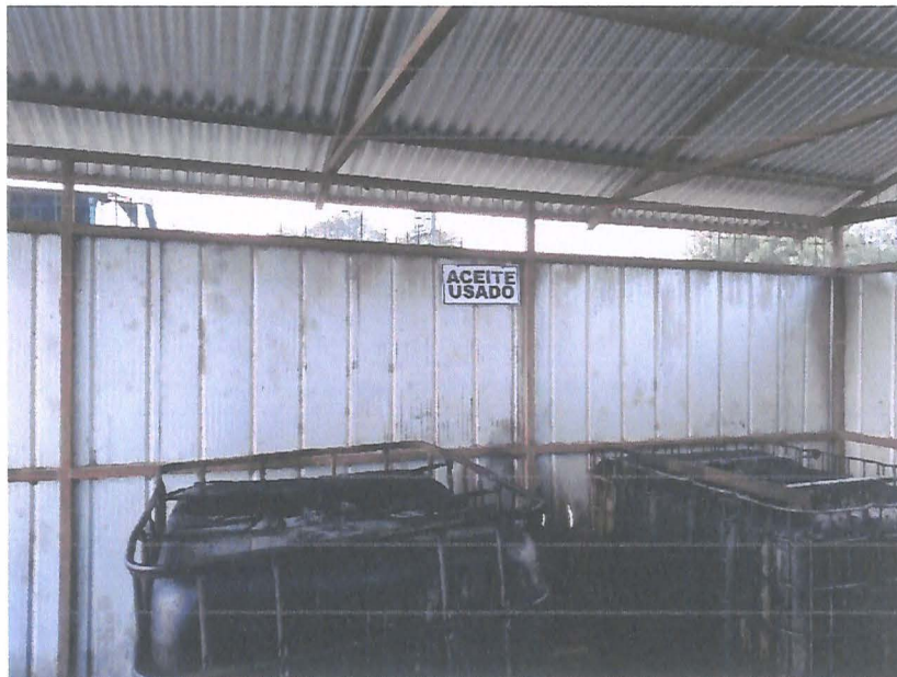
Rotulación Bins con Aceite Usado, Contenedores que serán reemplazados
