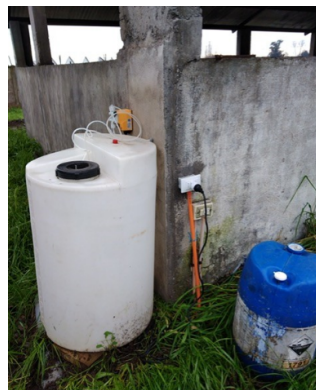
Foto 4 y 5: Cámara de cloración y Bomba para la inyección de Hipoclorito
