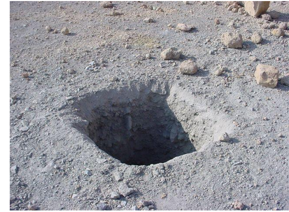
Cámara de inspección (2005)
