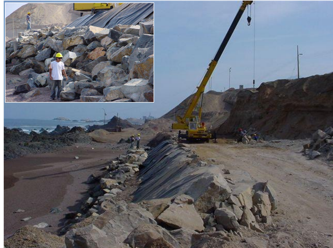
Envergadura del muro de protección, en especial su ancho que va desde la carpeta de HDP hasta los rípios que aparecen al costado derecho. (2005)
