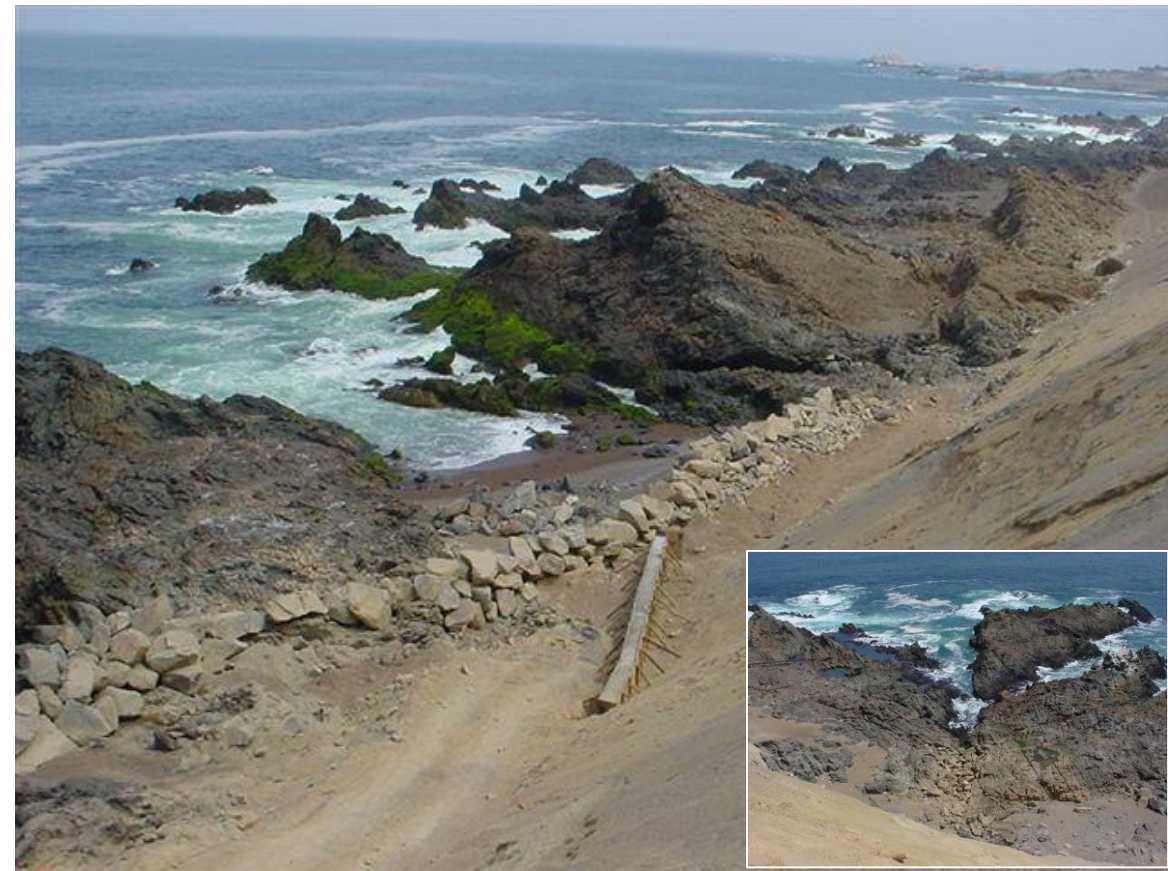
Vista superior de enrocado adicional que se construyeron, detrás de los enrocados en las entradas de mar. En costado izquierdo enrocado en entradas de mar (2005)
