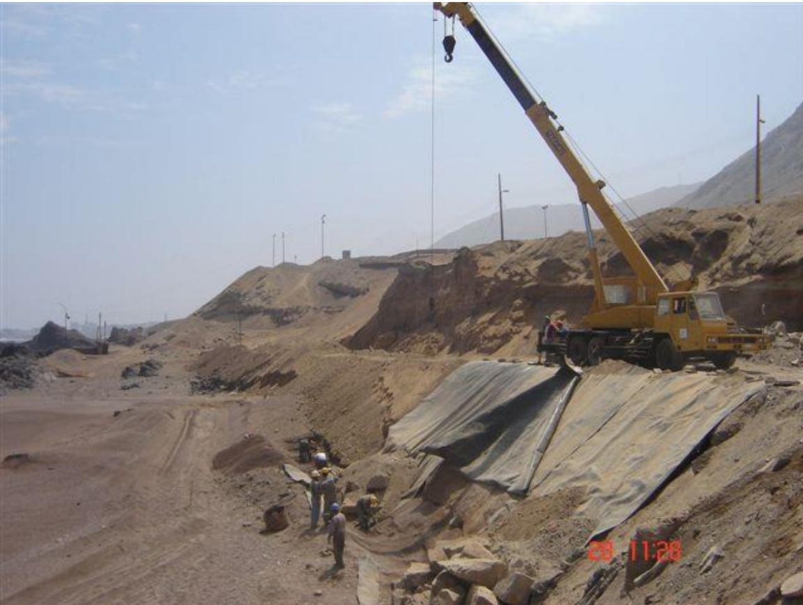
Inicio del enrocado del muro protección al pie del talud de los antiguos rípios. La foto da cuenta de la excavación de 1,5 m aproximados bajo el nivel de la playa para colocar rocas de gran tamaño en la base. (2005)
