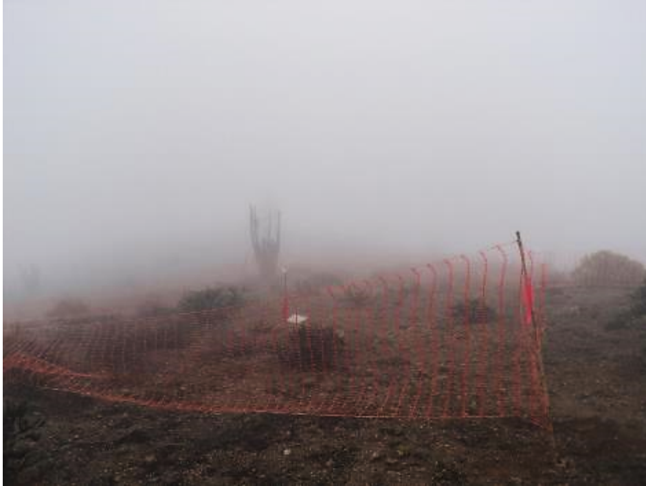
Fotografía 36: Delimitación de áreas de trabajo en base torre, T10, octubre 2016 (UTM E: 354797, UTM N: 7234098). Datum WGS 84, UTM 19 Sur.
