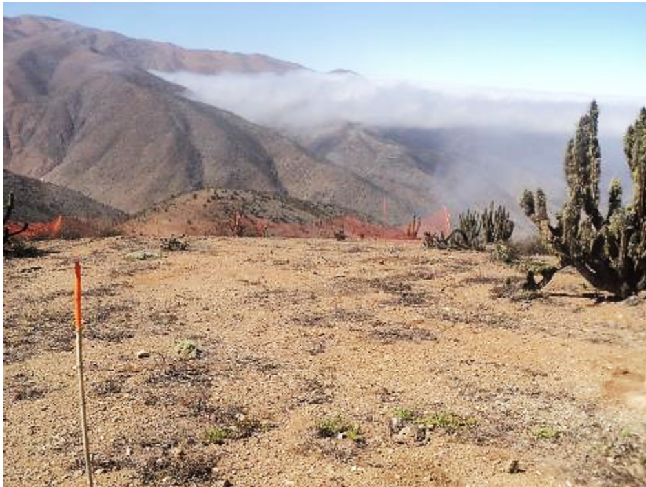
Fotografía 39: Delimitación de áreas de trabajo en camino de acceso a torre, T9, octubre 2016 (UTM E: 354666, UTM N: 7233990). Datum WGS 84, UTM 19 Sur.
