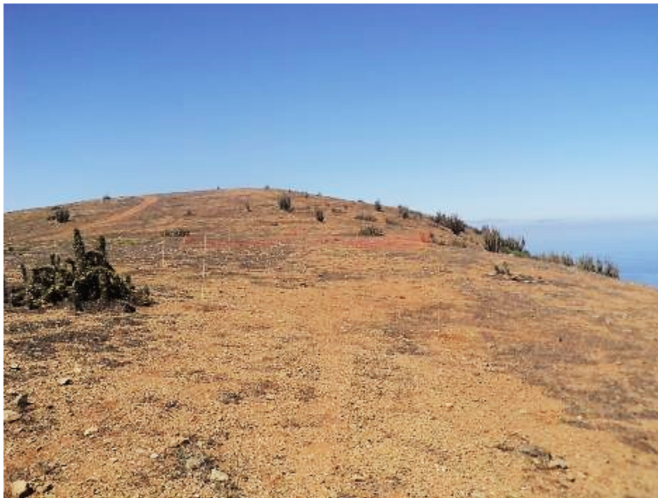
Fotografía 44: Delimitación de áreas de trabajo en camino de acceso a torre, T7, octubre 2016 (UTM E: 353874, UTM N: 7234072). Datum WGS 84, UTM 19 Sur.
