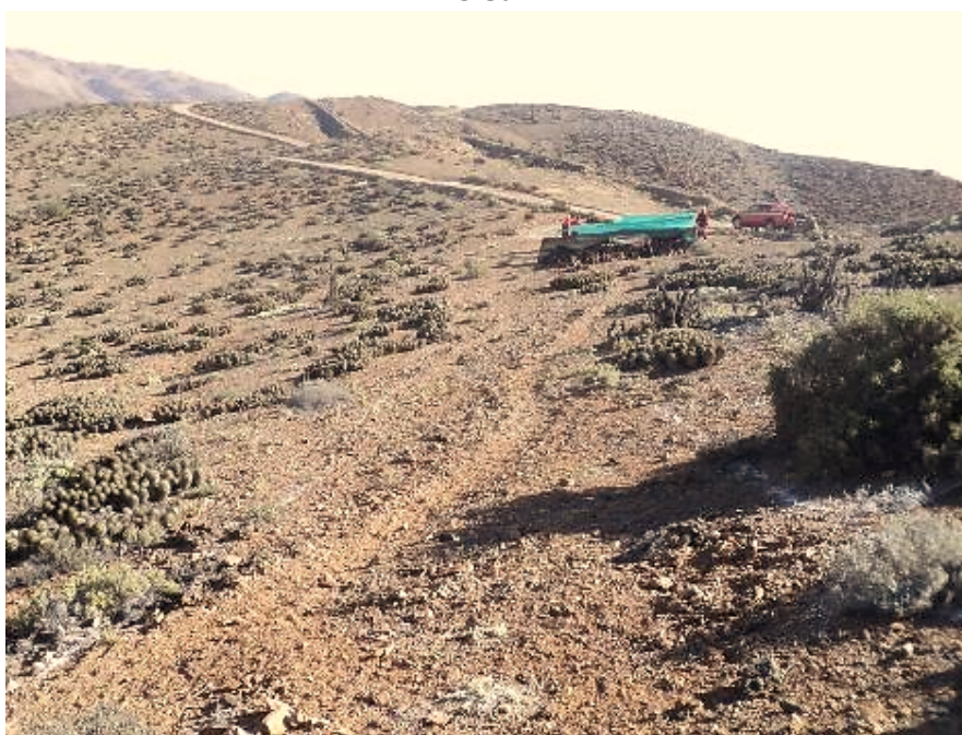
Fotografía 33: Acopio T12, liberación y delimitación de áreas de trabajo en camino de acceso modificado a torre, T12, octubre 2016 (UTM E: 355188, UTM N: 7234498). Datum WGS 84, UTM 19 Sur.
