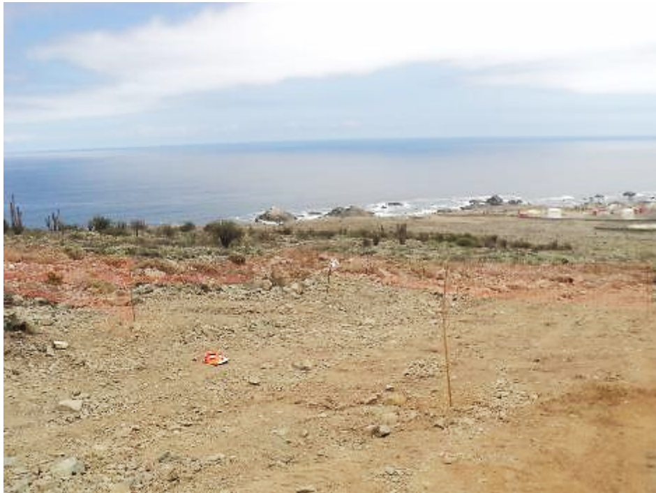
Fotografía 47: Delimitación de áreas de trabajo en base torre, T3, octubre 2016 (UTM E: 352893, UTM N: 7234963). Datum WGS 84, UTM 19 Sur.
