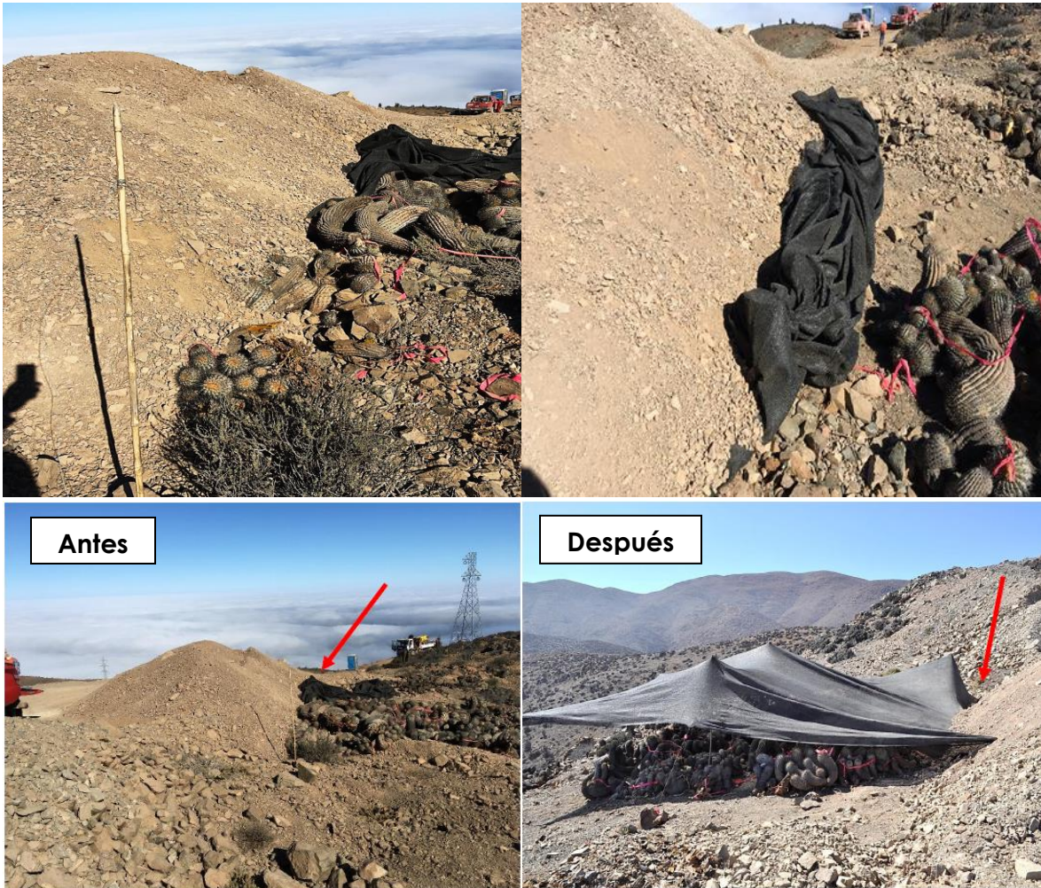
Figura 7. Sombreadero con material de excavación y despeje
