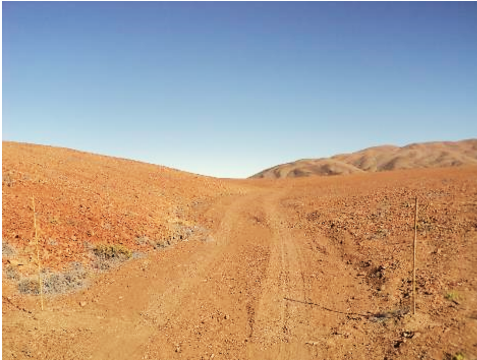
Fotografía 22: Delimitación de áreas de trabajo en camino de acceso a torre, T18, octubre 2016 (UTM E: 356535, UTM N: 7236327). Datum WGS 84, UTM 19 Sur.
