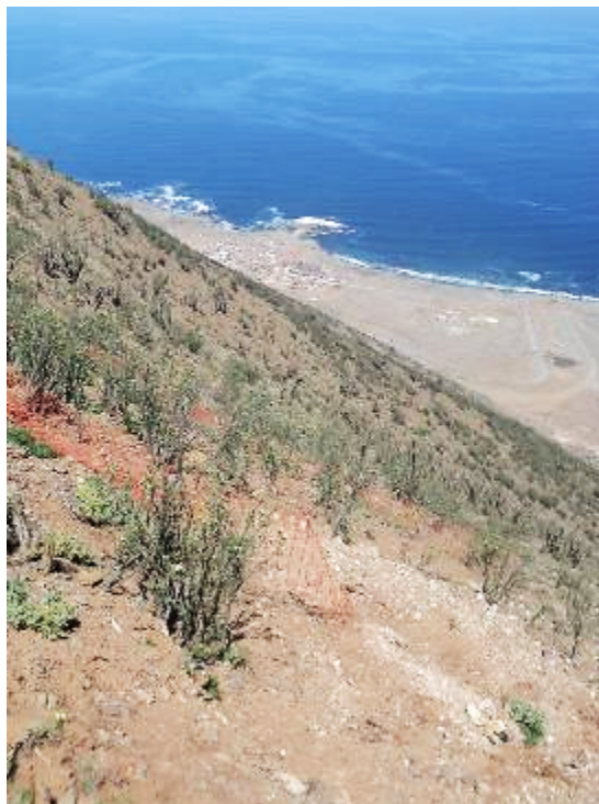
Fotografía 45: Delimitación de áreas de trabajo en base torre, T6, octubre 2016 (UTM E: 353824, UTM N: 7234108). Datum WGS 84, UTM 19 Sur.
