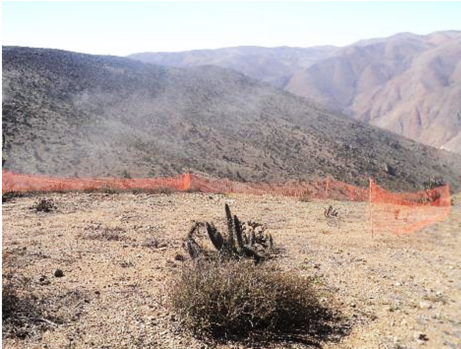
Fotografía 38: Delimitación de áreas de trabajo en base torre, T9, octubre 2016 (UTM E: 354668, UTM N: 7233967). Datum WGS 84, UTM 19 Sur.
