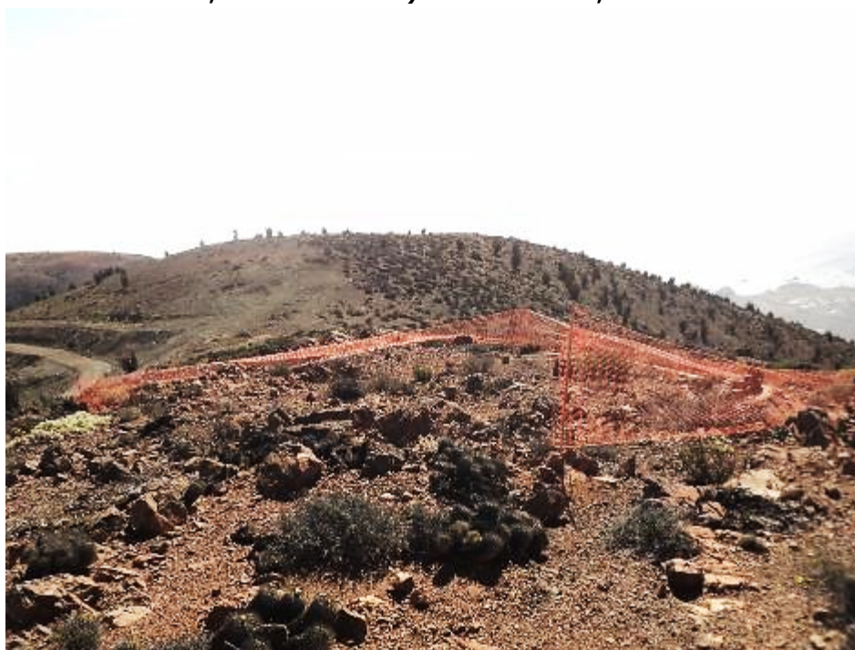
Fotografía 34: Delimitación de áreas de trabajo en base torre, T11, septiembre 2016 (UTM E: 354960, UTM N: 7234256). Datum WGS 84, UTM 19 Sur.
