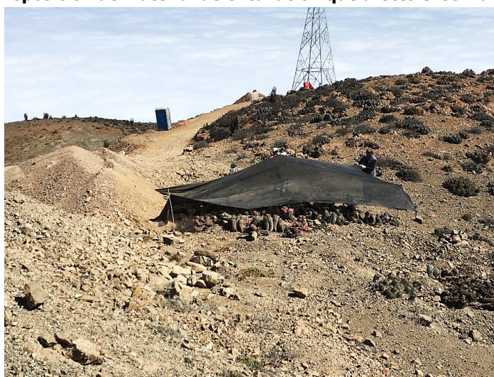
Fotografía 10: Disposición de material de excavación que afectó el sombreadero de la T11
