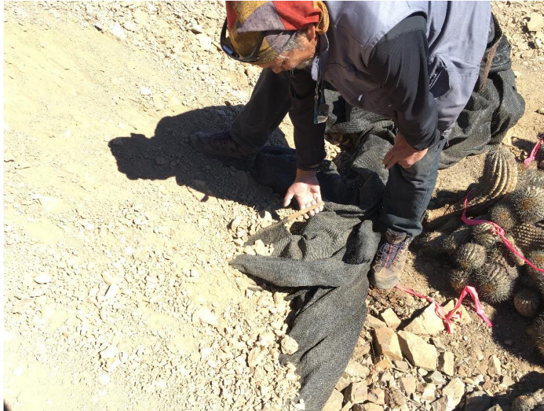
Fotografía 12: Proceso de retiro del material de excavación sobre el sombreadero T11.
