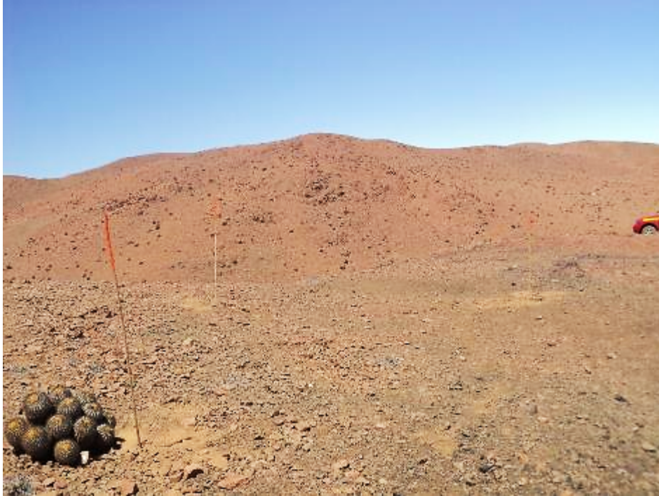
Fotografía 26: Delimitación de áreas de trabajo en camino de acceso a torre, T16, octubre 2016 (UTM E: 356328, UTM N: 7235691). Datum WGS 84, UTM 19 Sur.
