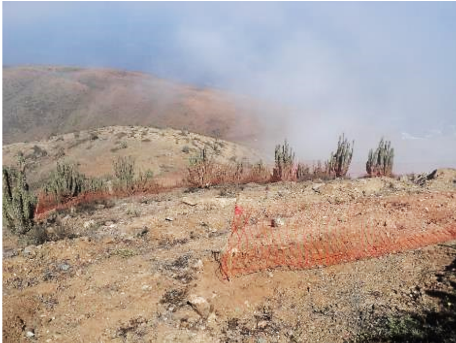
Fotografía 40: Delimitación de áreas de trabajo en base torre, T8, octubre 2016 (UTM E: 354612, UTM N: 7233974). Datum WGS 84, UTM 19 Sur.
