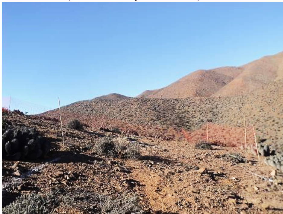
Fotografía 32: Delimitación de áreas de trabajo en base torre, T12, octubre 2016 (UTM E: 355188, UTM N: 7234498). Datum WGS 84, UTM 19 Sur.
