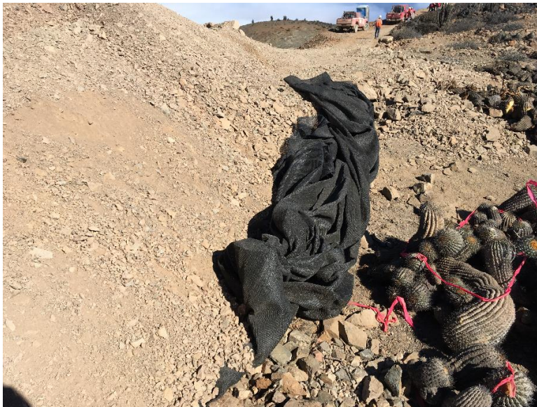
Fotografía 13: Retiro total del material de excavación y alejamiento de los individuos afectados y cercanos, sombreadero T11.
