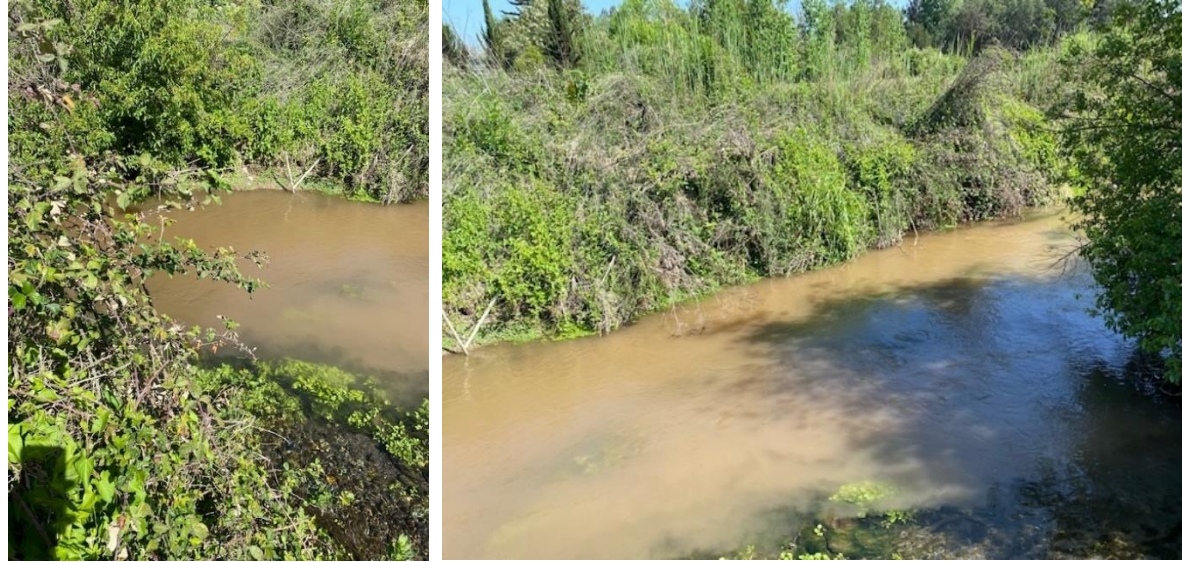
Figura 3.2– Vista Aguas Arriba y Aguas Abajo – Punto de Descarga Proyectado A
