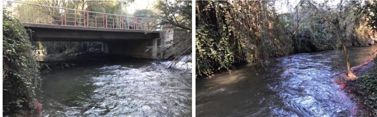
Figura 3.3– Vista Aguas Arriba y Aguas Abajo – Punto de Descarga Proyectado B
