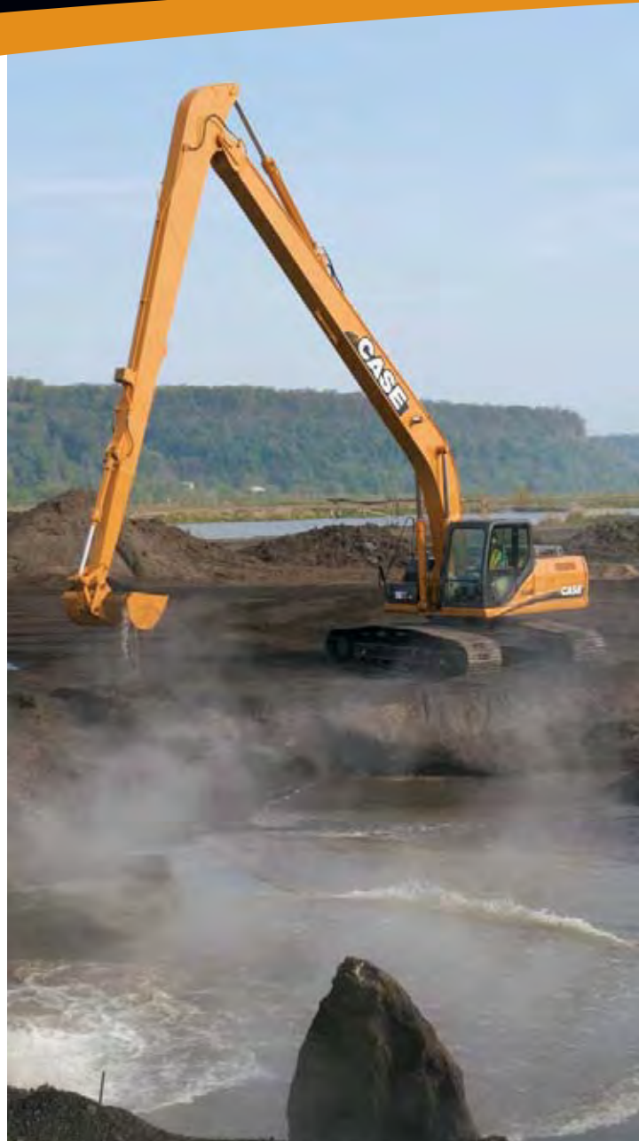
Excavación de zanjas (DTCH)
