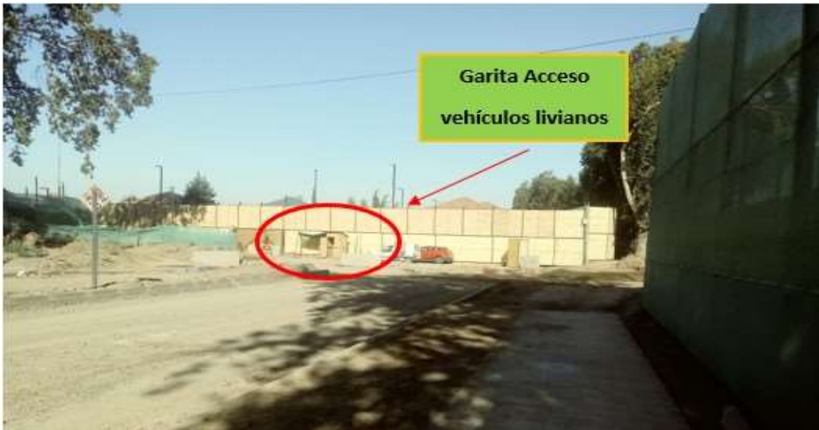
Figura 7. Garita de acceso calle Los Cerezos Fuente: Google Earth, Fecha 12-07-2018 (Coordenadas: 354.455,35 E; 6.293.384,93 N)
