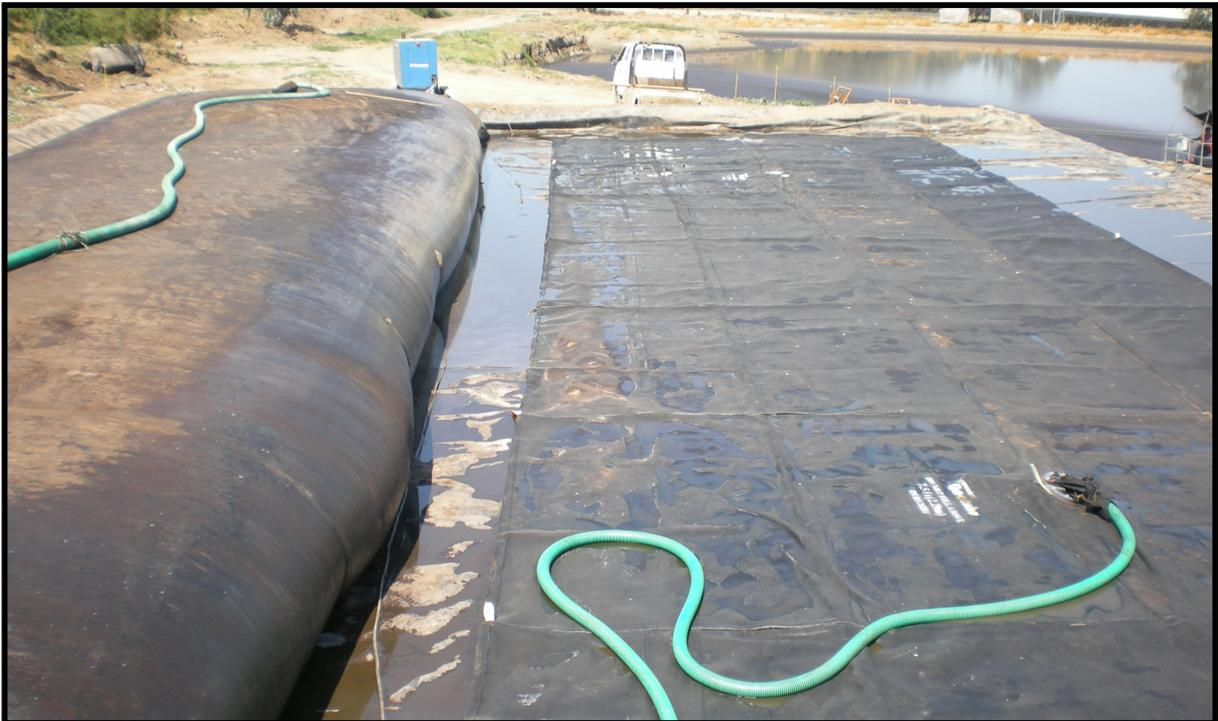
**Figura 5.** Cancha de geotubos y proceso de llenado.
