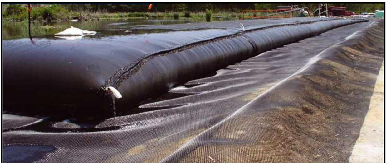
**Figura 7.** Esquema de pretil (cancha) necesario para instalar geotubos.
