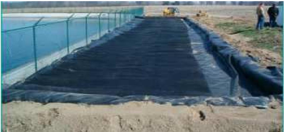
**Figura 9.** Fabricación de pretil
