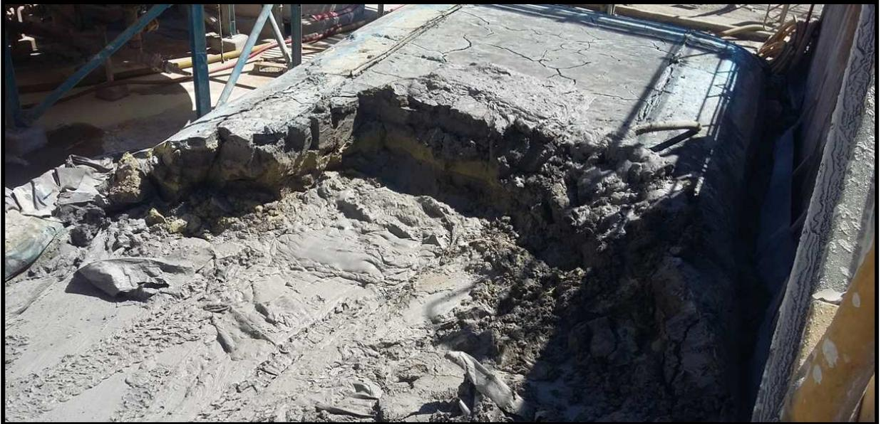
**Figura 10.** Referencia de formación de torta al cortar geotubo.
