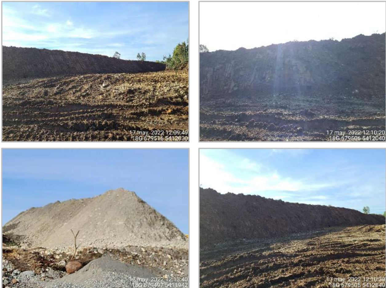
Figura 3: Barrera Acústica compuesta por acopio de material en frente activo de trabajo.
