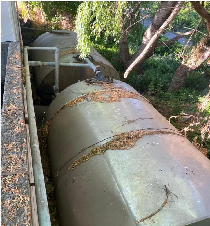
Imagen 8: Digestor de lodos:
