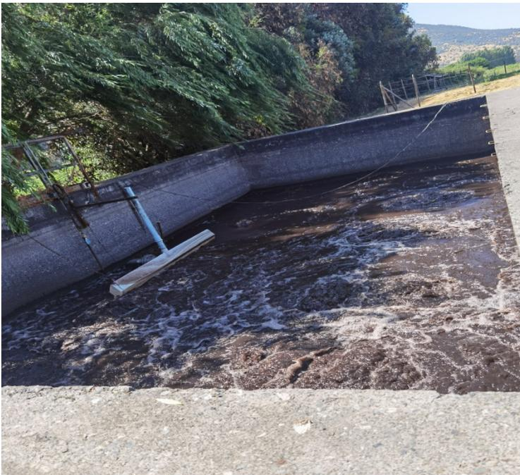
Imagen 3: Limpieza de bomba sumergible con sensor de nivel ubicada en estanque ecualizador:
