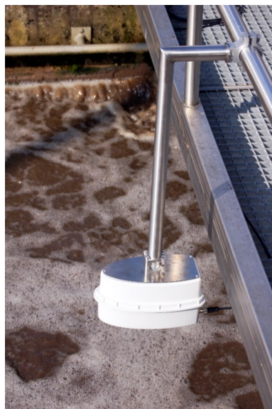
Figura 21 La instalación del sensor con Cubo de montaje
