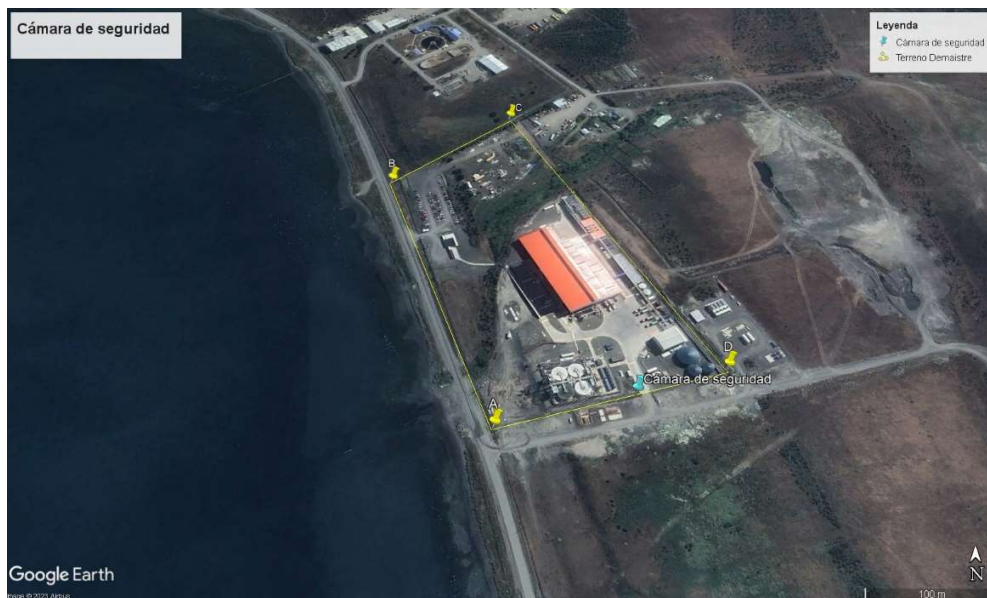
Imagen N°6: Posición de cámara de seguridad.
