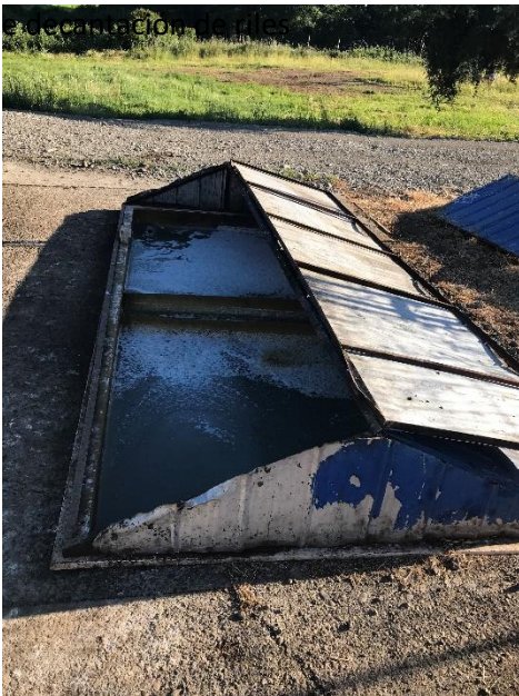
Primer ingreso del Ril en la piscina de decantación
