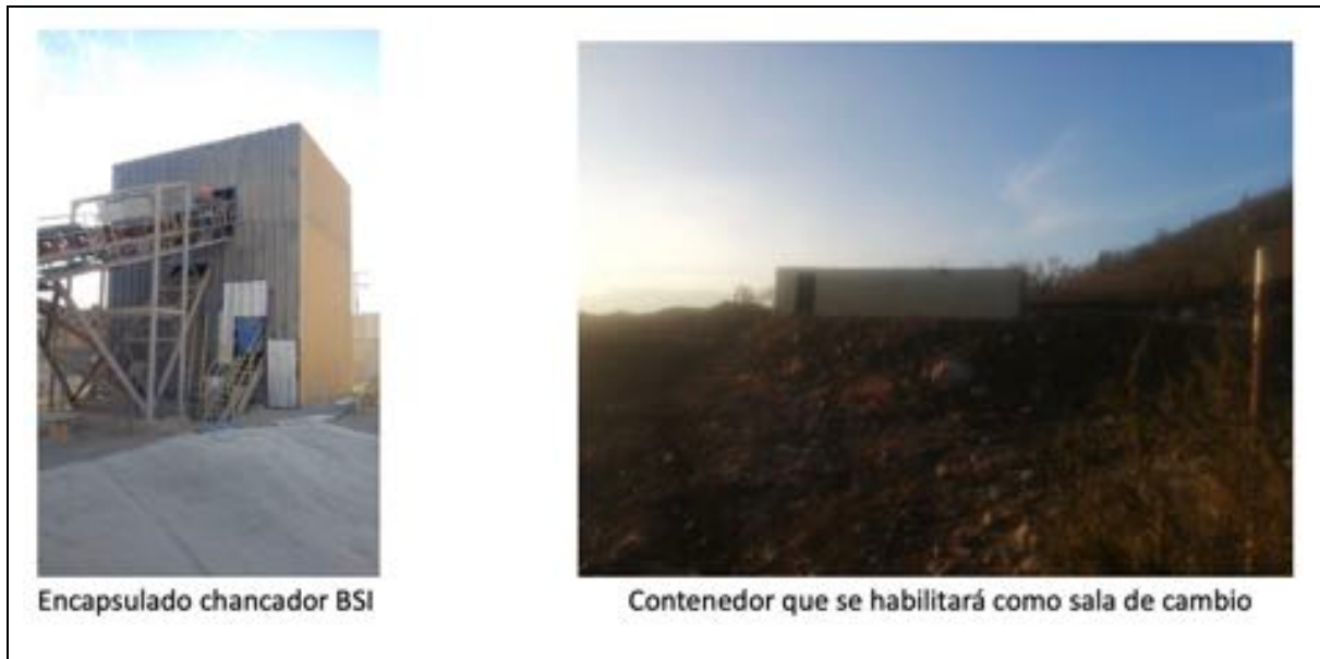
Figura 5: Encapsulamientos de la planta de procesamiento
