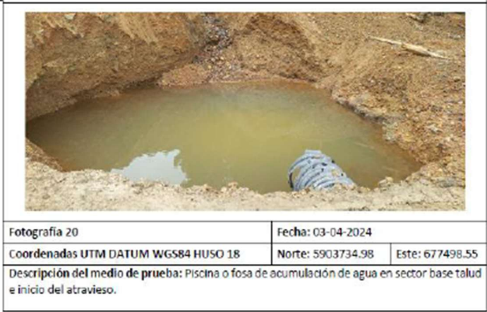
Figura 11. Fosa de acumulación de agua en sector base talud
