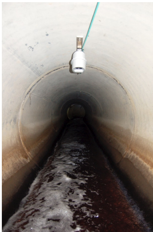
Figura 14 Instalación de un sensor SQ en un canal de descarga de agua
