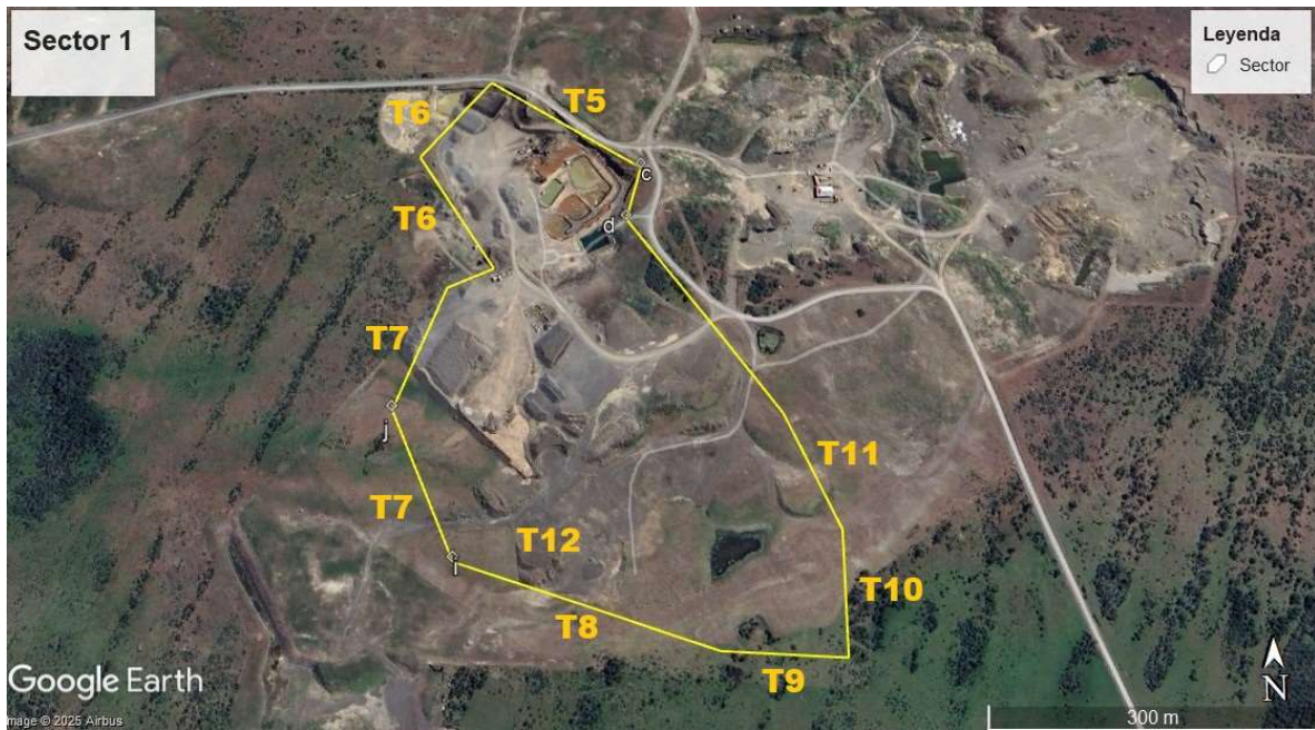
Figura 2. Detalle de taludes en el sector 1.
