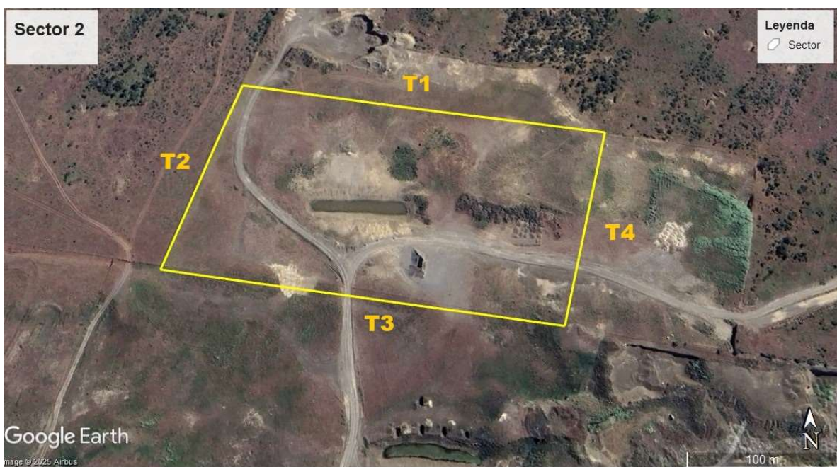
Figura 3. Detalle de taludes en el sector 2.
