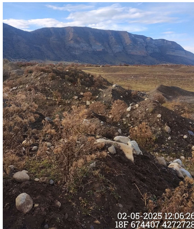
Imagen 17. Registro del estado actual del Talud T1.
