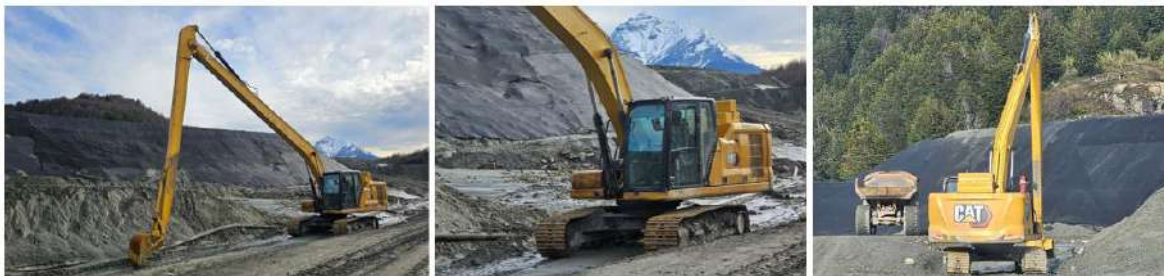
Figura 3: Maquinaria Pesada Para Extracción de Relaves Solidos
