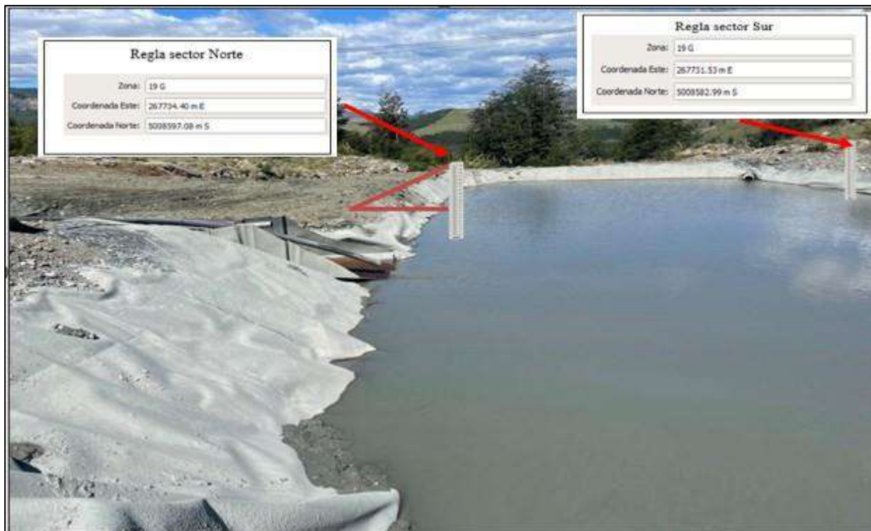
Imagen N°2. Reglas instaladas en la piscina
