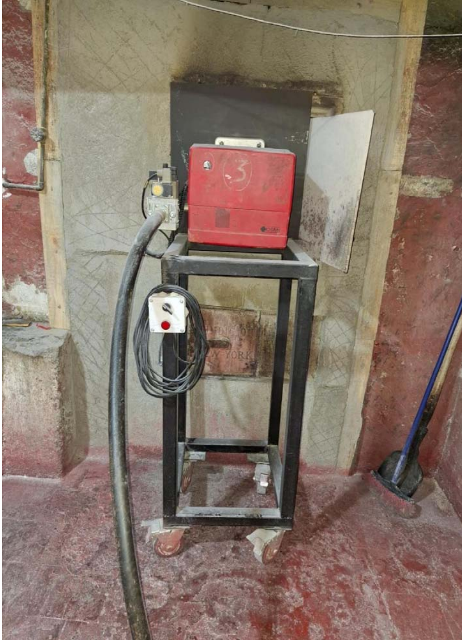
Foto corresponde a entrada de Quemador de Gas Licuado
