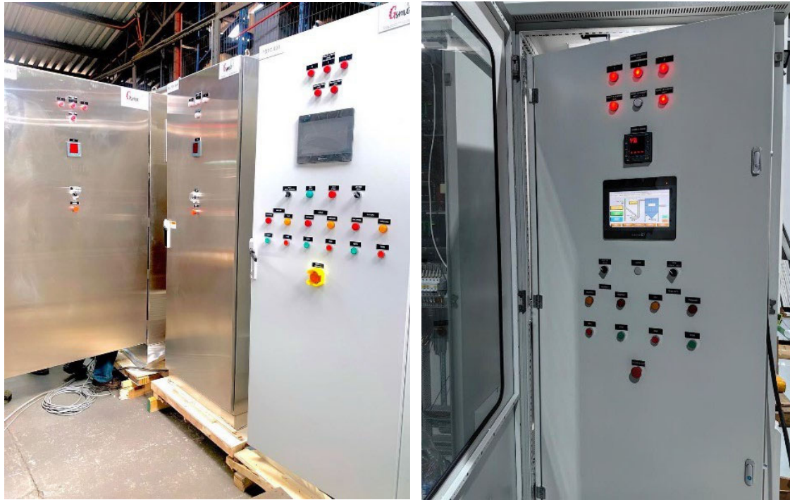
Ilustración 13: Tablero de fuerza y control local GSMI (Imagen referencial).
