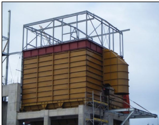
Cementos Bío-Bío; Ingeniería, Fabricación y Suministro Filtro de mangas 186.000 m 3 /h.
