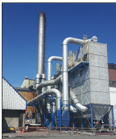
IANSA; Ingeniería, Fabricación y Suministro de Filtro de Mangas de 165.748 m 3 /h.
