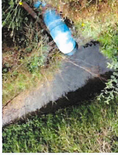
Fotografía N° 4: Visita inspectiva, IMG_3056, 27.03.2018
