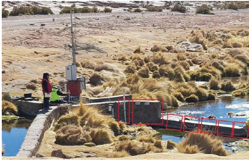
Imagen 1. Refuerzo muros vertedero chico
