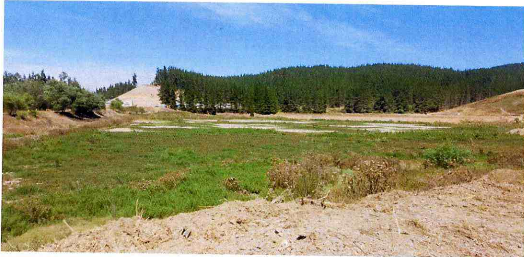
Vista desde Nororiente. Sectores 2, 3 y 4. Cierre Ex Laguna Tratamiento Efluentes. 9 de febrero de 2017
