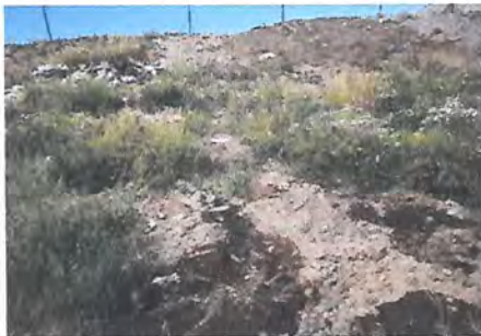
Taludes con sobre cobertura en exceso
