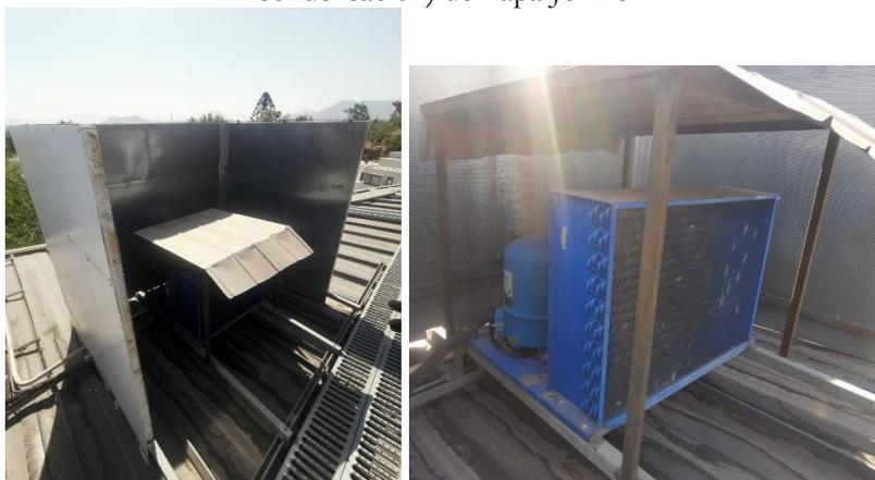
De una visita a la techumbre del Strip Center se determinó que el equipo anterior tiene una carga sonora notoriamente superior al resto de los dispositivos de los otros locatarios, además de identificarse de que actualmente cuenta con un tabique acústico que disminuye el nivel de ruido en su parte posterior (hacia las residencias colindantes). Las coordenadas UTM de referencia de georreferenciación de la imagen captada son: E: 357199.04; N: 6298845.79, uso 19.
