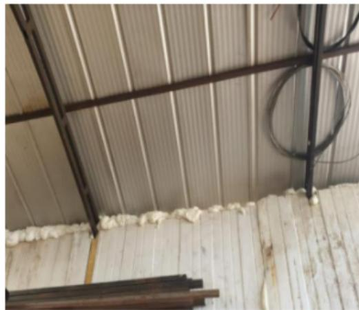
Muro de 150mm de espesor, con aislante de poliuretano expandido de alta densidad, cuantificada en 40kg/m<sup>3</sup>, el cual cubre completamente hasta la cubierta
