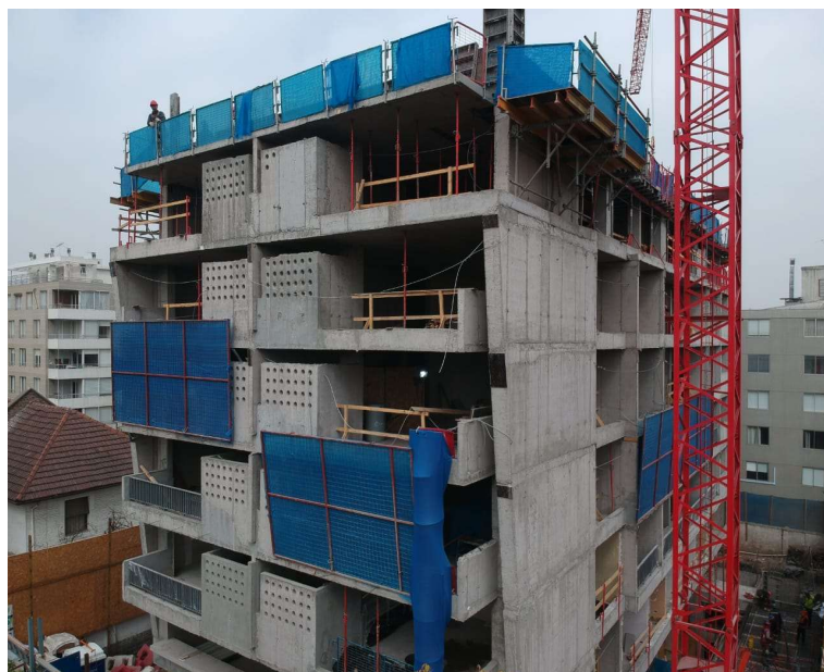
Figura 2: Trabajos que se estaban realizando a la fecha de la denuncia (Hormigado de piso de la corona)
