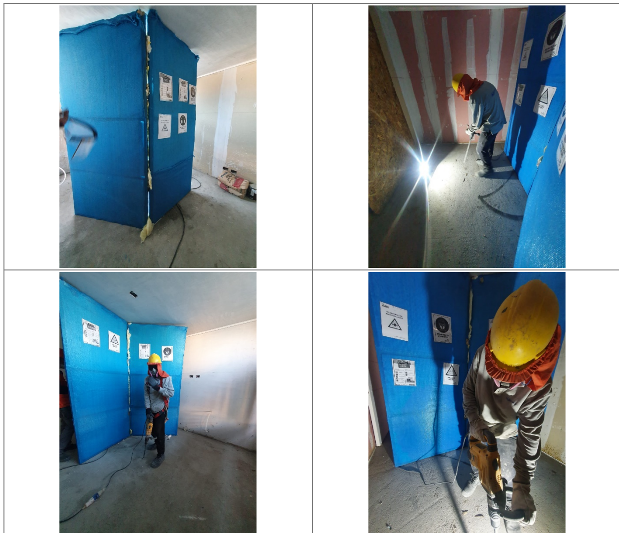
FIGURA 6. BIOMBOS ACÚSTICOS IMPLEMENTADOS EN FAENA MANUEL MONTT 1204.
