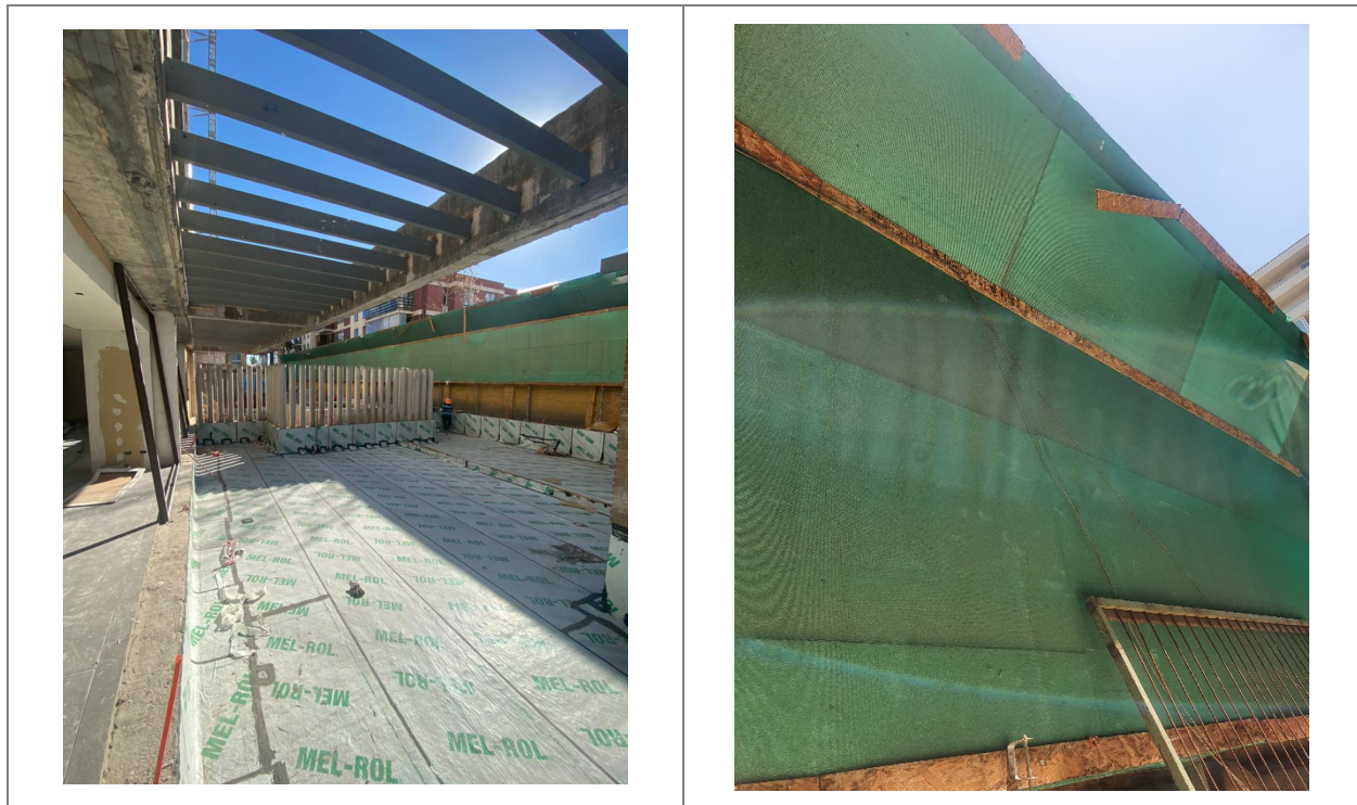
FIGURA 2. IMAGEN DE CIERRE PERIMETRAL EN OBRA MANUEL MONT 1204.
