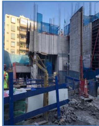
Figura 3. Rotomartillos Preparando Muros y Losas.
