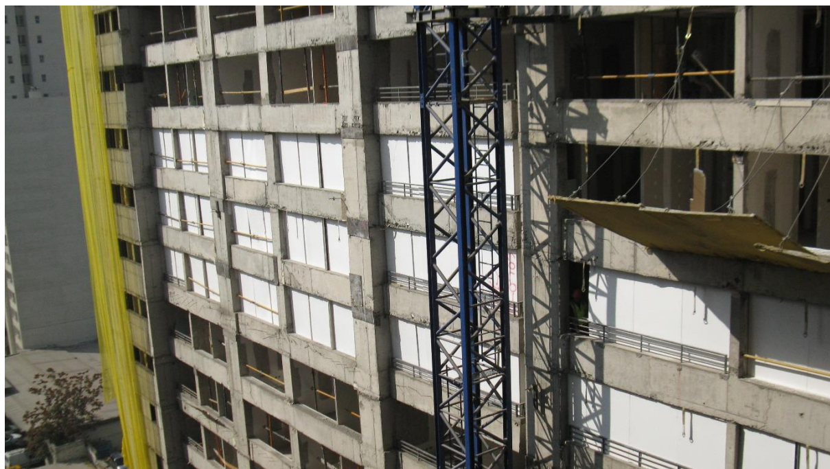
Figura 7. Imagen referencial edificio con cierre de vanos.
