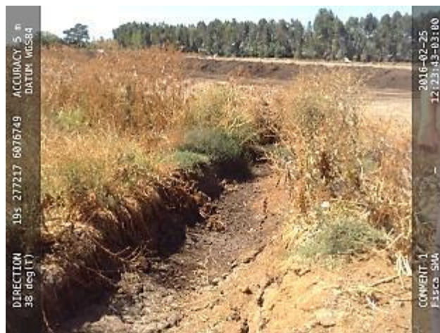
Descripción Medio de Prueba: Fotografía de la zanja perimetral para la recolección de aguas lluvia implementada en la Guanera 4.
