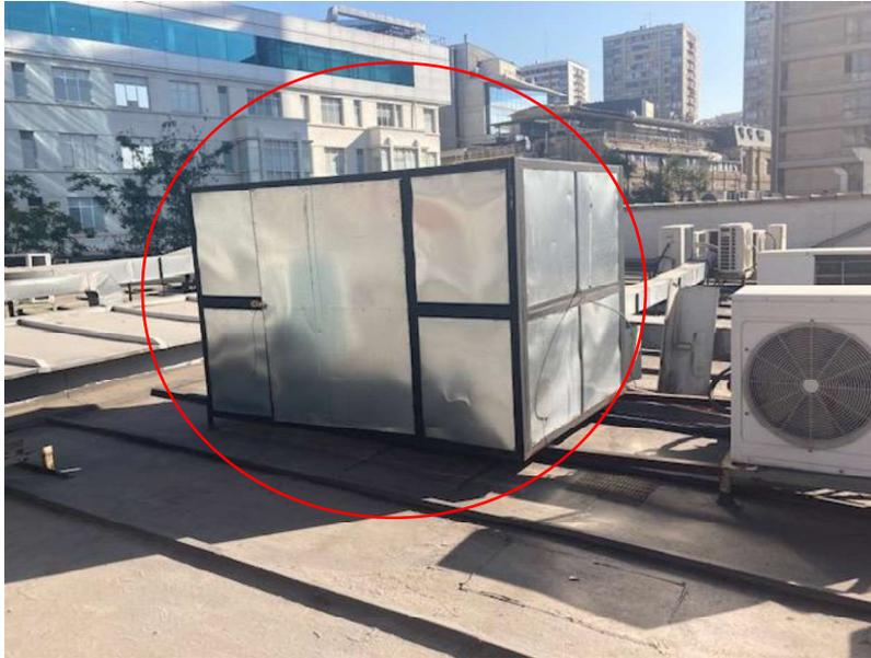
**Imagen N° 4.** Caja para atenuación de ruido unidad externa - equipo aire acondicionado. **Fuente:** Elaboración propia
