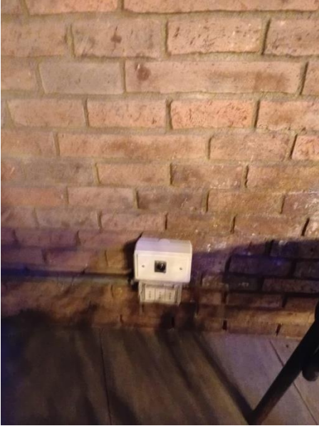
Cajas de conexión instaladas para DJs; cableado oculto
