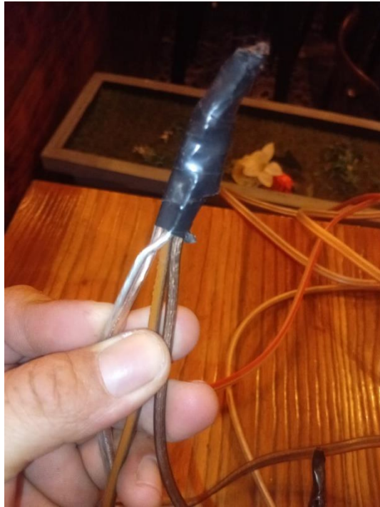
Empalme distinto calibre
