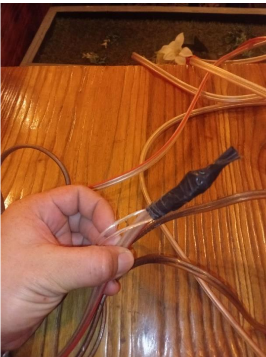
Empalme de cable paralelo distinto calibre
