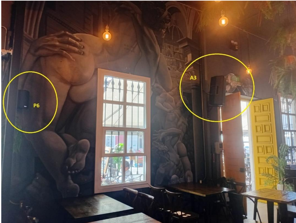
Parlante pasivo interior: P6; Parlante activo interior: A3.
