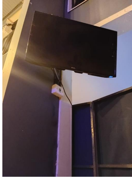
Cajas de conexión instaladas para DJs; cableado oculto
