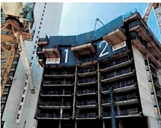
Confinamiento faenas en altura
