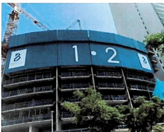
Confinamiento faenas en altura
