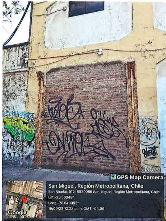
Ilustración 22. Muro área de mantención
