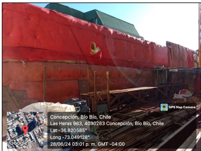
Imagen N°1: Barrera acústica instalada (1)
