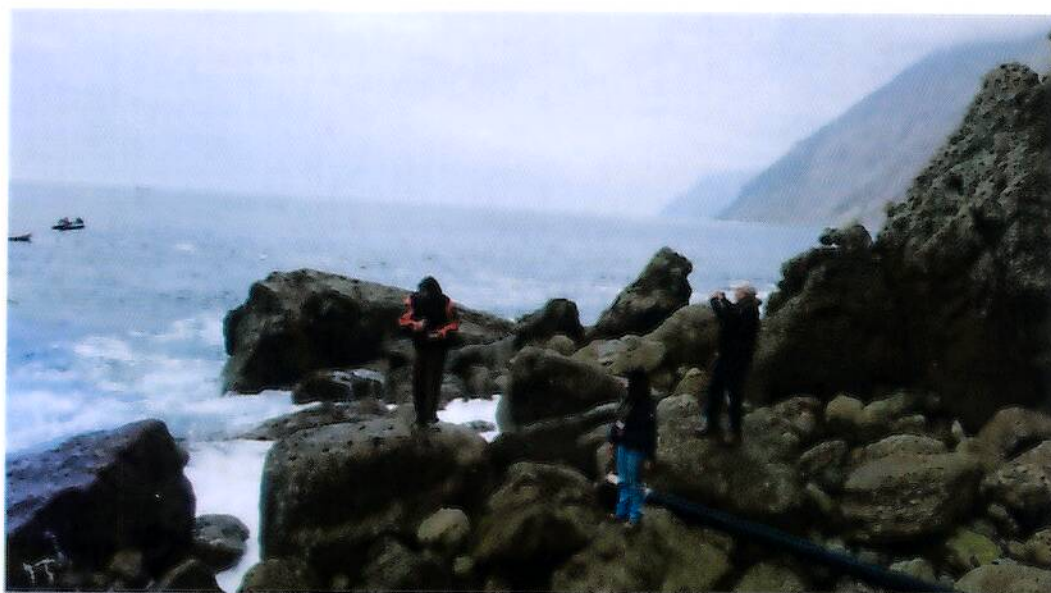
Fotografía 1: Tubería en lugar de aducción de agua de mar, sector "Punta Madrid".
