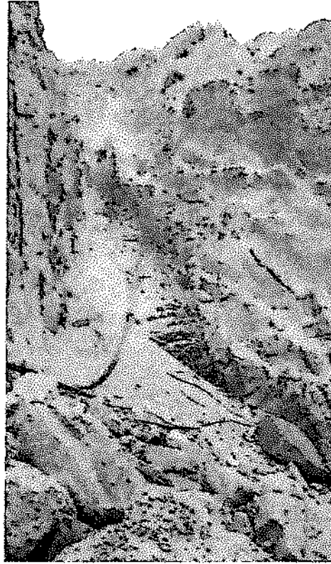
Fotografía 2: Vista de acantilado con tubería de aducción de agua de mar, sector "Punta Madrid".
