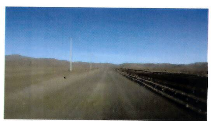
Figura N° 11: Tubería camino a Piscina de Agua de Mar.
