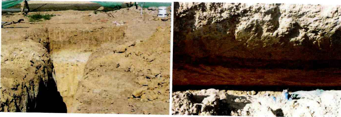
Vista de la zanja en proceso de retiro de material.
