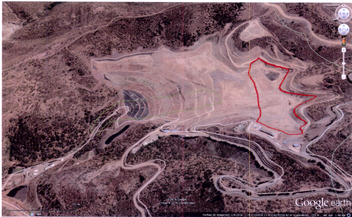
Figura 4: En rojo se demarca la proyección de la celda N° 1, en verde la zona de deslizamiento. (Fuente: Consorcio Santa Marta).
