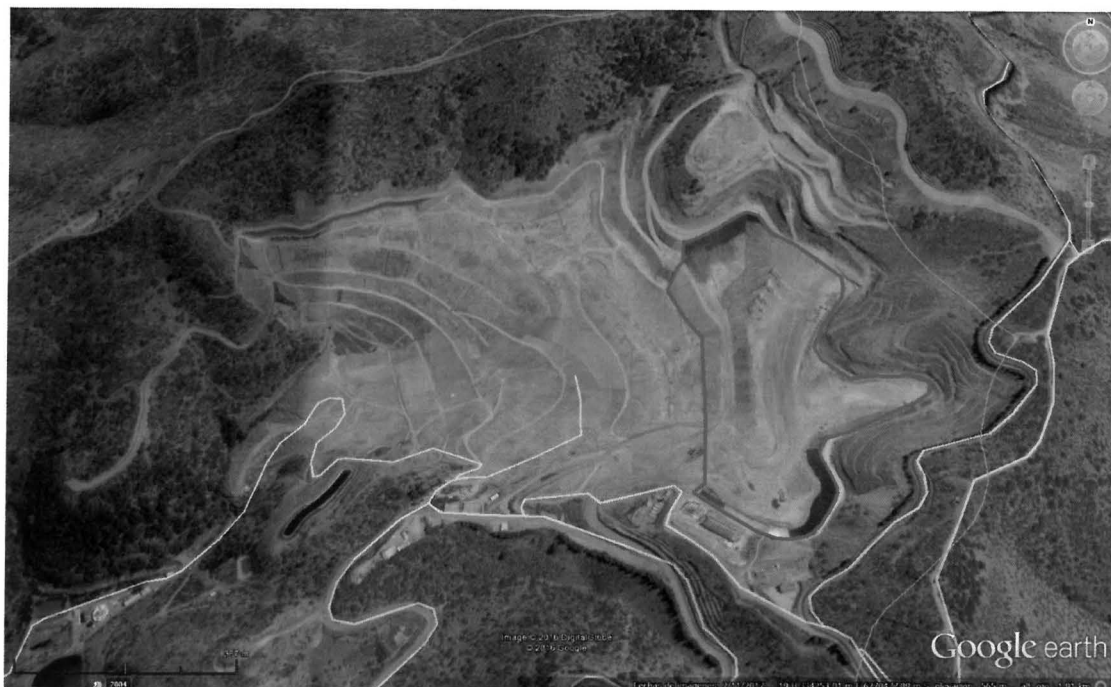
Figura 6: En rojo se demarca la proyección de la Zona de Seguridad (Celda N°1 y Sobrecelda), (Fuente: Google Earth, imagen del 11 de febrero de 2017).
