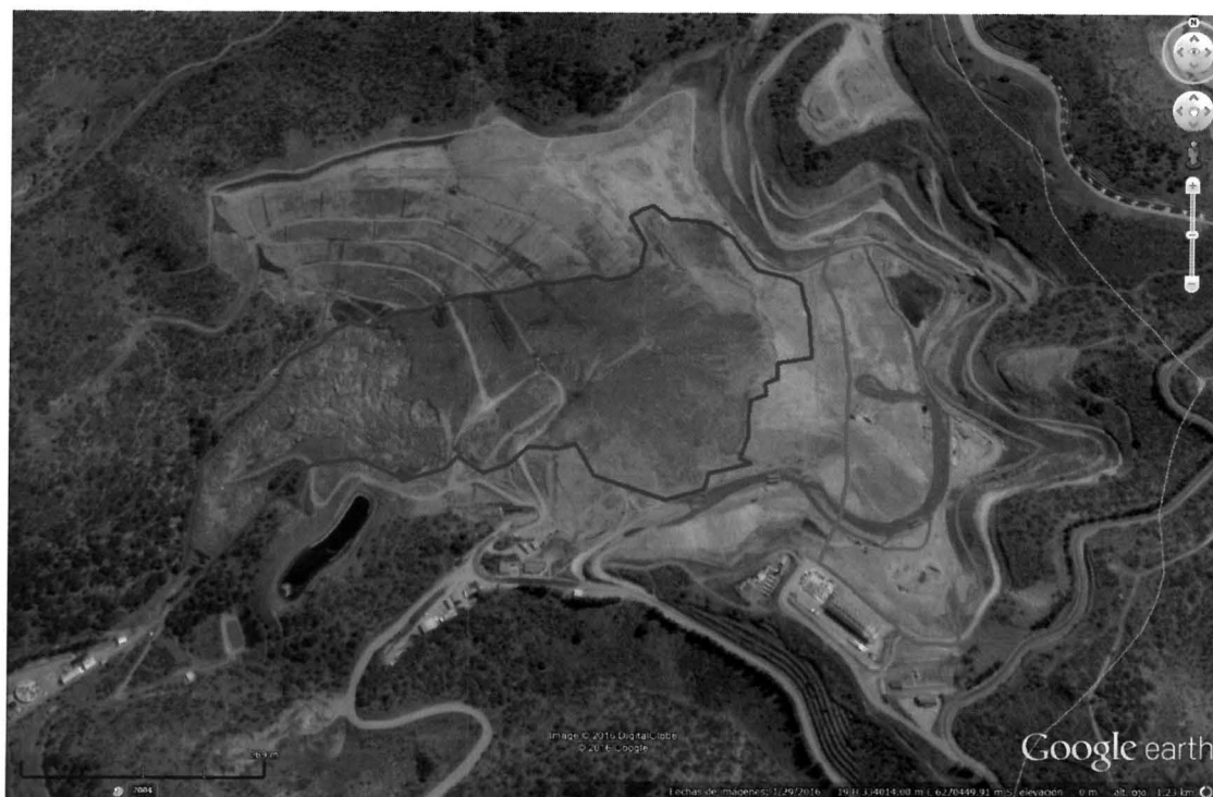
Figura 4: En rojo se demarca la proyección de la Celda N° 1, en verde la zona de deslizamiento. (Fuente: Google Earth, imagen del 29 de enero 2016).
