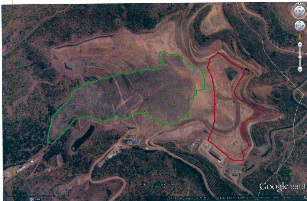
Figura 4: En rojo se demarca la proyección de la Celda N° 1, en verde la zona de deslizamiento. (Fuente: Google Earth, imagen del 29 de enero 2016).
