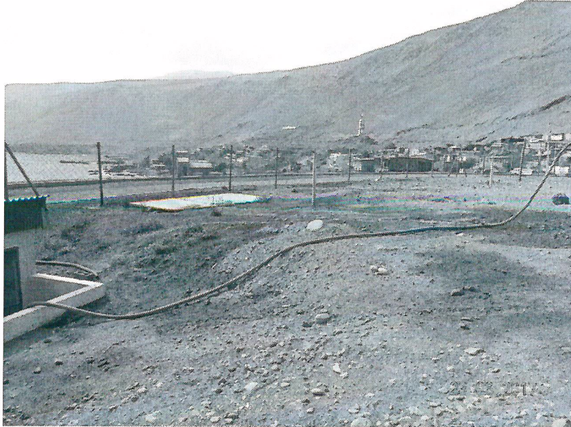
Fotografía 5: Filtración de aguas servidas sobre el terreno, al momento de la inspección
