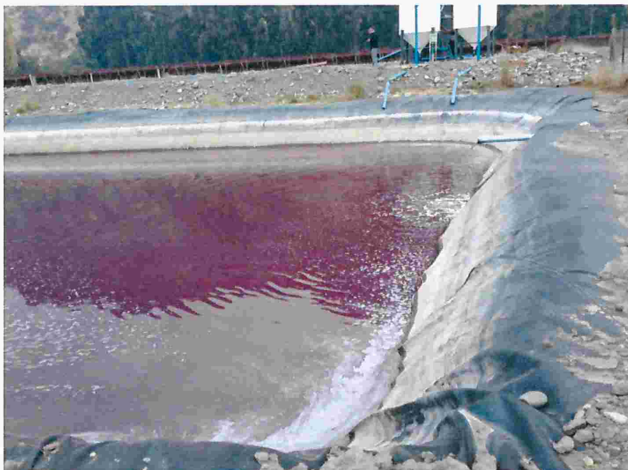
Imagen N° 4. Piscina de acumulación. Coordenadas DATUM WGS84 HUSO 19. Norte 6.210.769 m, Este 326.237 m. 4
