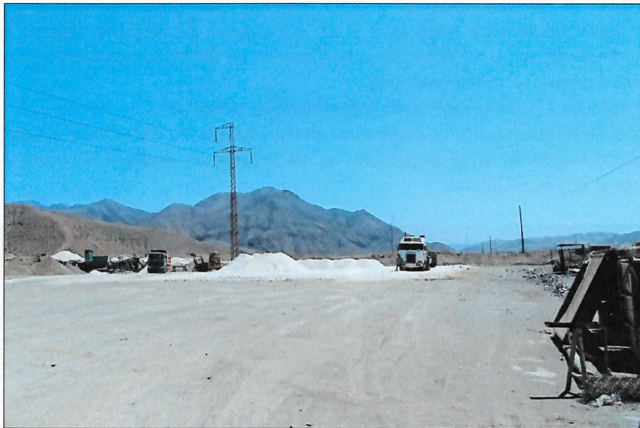
Figura 9. Al acercarnos al área de tratamiento de sal se observan a distancia los primeros acopios de ésta dispuestos sobre suelo desnudo y sin delimitación del área de acopio.
