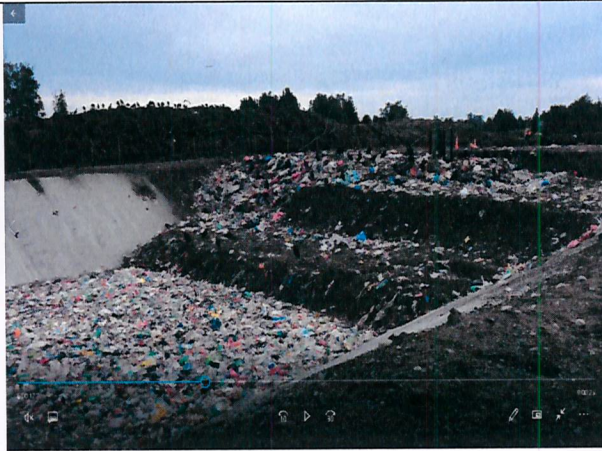
Fotografía N°1: Se constata aposamiento de aguas lluvias en el fondo de zanja de disposición cubierta de plásticos sobrenadantes (circulo rojo) y basura descubierta
