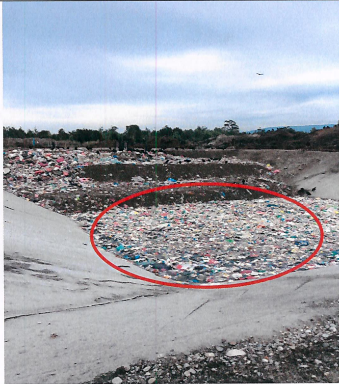
Fotografía N°1: Se constata aposamiento de aguas lluvias en el fondo de zanja de disposición cubierta de plásticos sobrenadantes (circulo rojo) y basura descubierta
