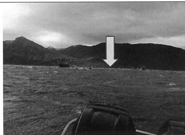
Imagen N°4: Vista general hacia CES Caicura.
