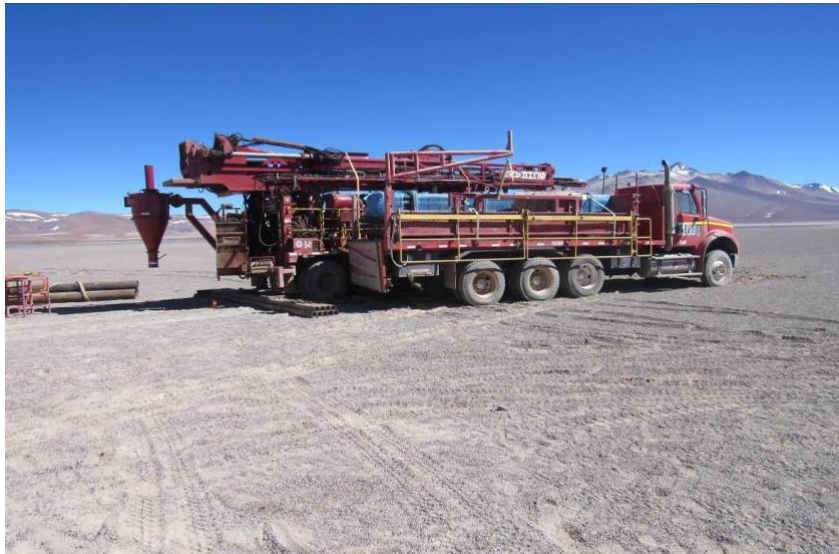
Figura 3.- Imagen de maquinaria en sector de instalación auxiliar temporal (02-12-2018)
