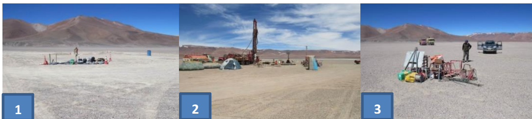
Figura 2.- Imágenes de ubicación de puntos de sondajes denunciados por CONAF. Imagen 1: Almacenamiento de materiales y equipamiento de sondaje N° 1; Imagen 2: Instalación de sondaje N°2; Imagen 3: Punto proyectado de sondaje N°3.
