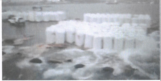
Imagen N°5: Muelle flotante en minutos antes de su hundimiento.
